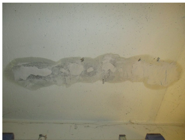
foto/12/ Pohled na zapravenou sondu S2
