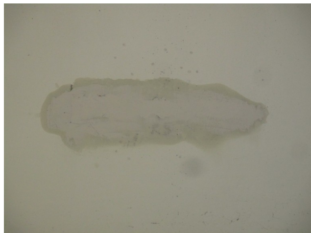
foto/8/ Pohled na zapravenou sondu S1
